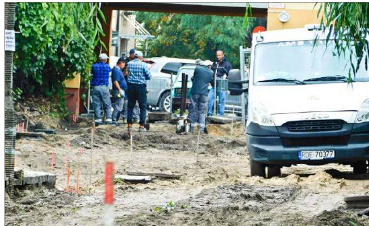
Remont zniszczonego parkingu przy Strażackiej trwa.
