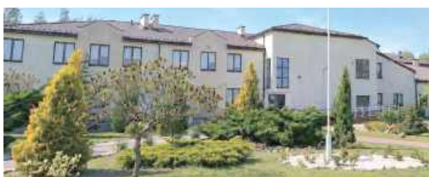
Po przybyciu na miejsce strażacy ustalili, że gniazdo znajduje się w elewacji budynku, na wysokości około trzech metrów
