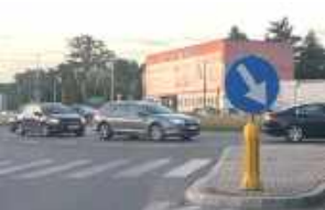
Od kilku dni kierowcy poruszający się w rejonie Kauflandu oraz Zespołu Szkół Ogólnokształcących w Dęblinie muszą liczyć się z utrudnieniami. W związku z prowadzoną inwestycją fragment jezdni został objęty remontem, a ruch odbywa się wahadłowo
