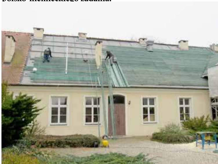
Zaawansowane prace na dachu
