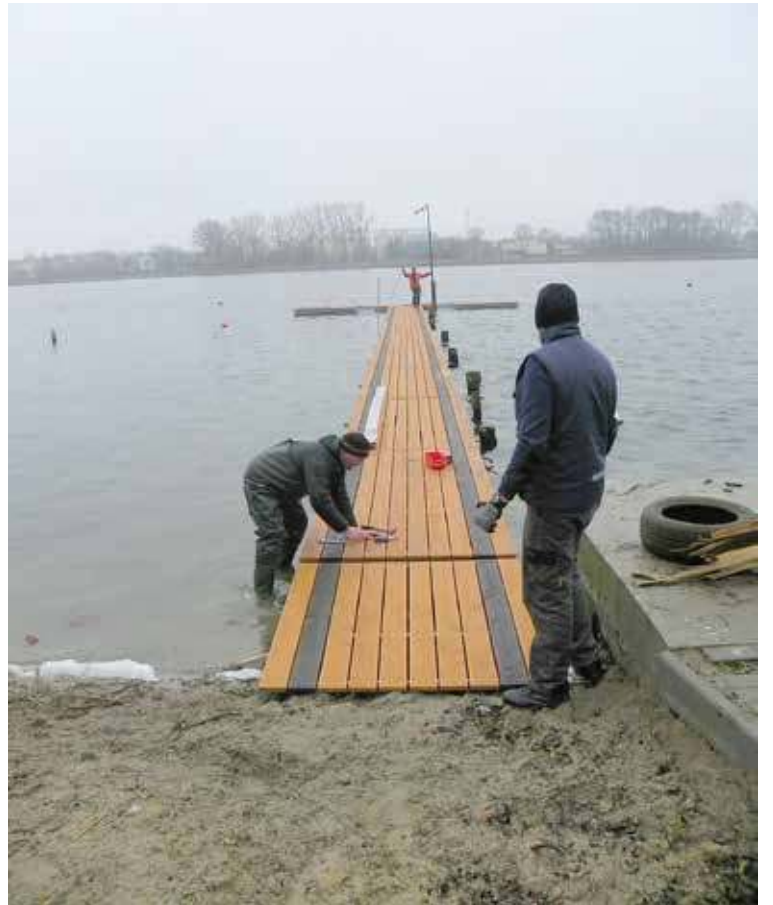
Budowa pomostu na dzień przed oddaniem technicznym obiektu dla żeglarzy
