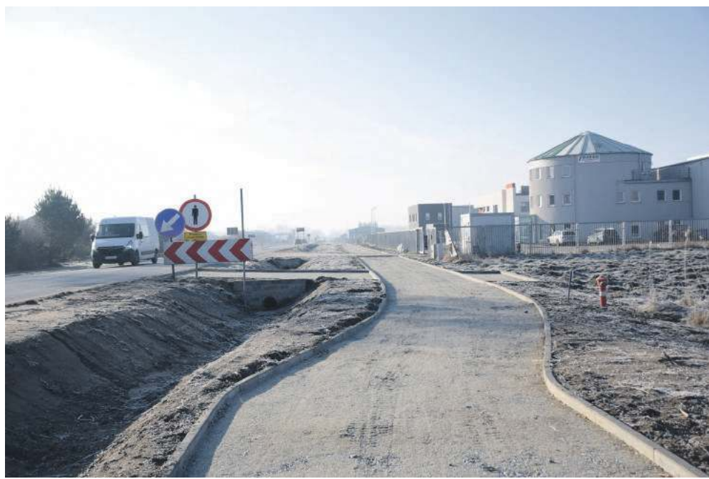
W Szewcach wzdłuż drogi wojewódzkiej trwa budowa ciągu pieszo-rowerowego
