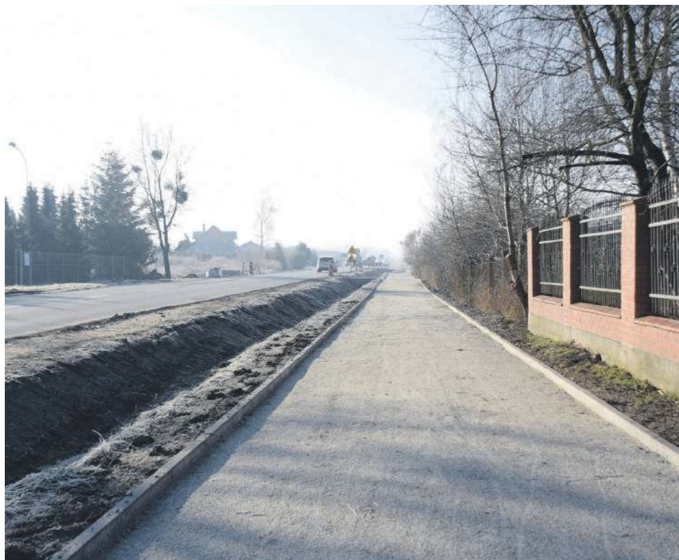
Budowany ciąg pieszo-rowerowy połączy gminę Wisznia Mała z Obornikami Śląskimi i Wrocławiem
