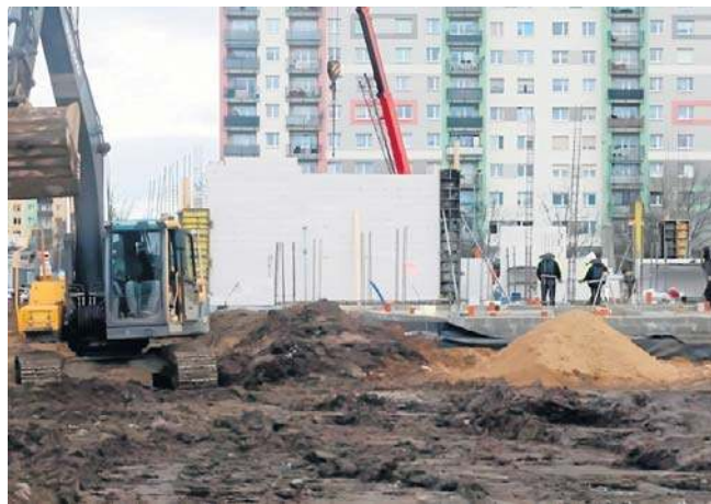
Trwa budowa żłobka przy ulicy Sikorskiego w Legnicy. Placówka przyjmie 100 dzieci
