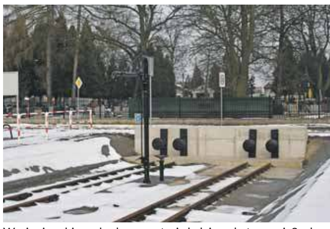
Wrażenie robi przebudowana stacja kolei wąskotorowej. Są dwa perony, wiaty, ławki, stanowisko do obsługi parowozu
