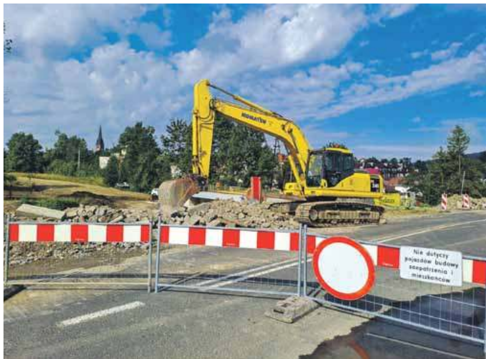
Prace na przejeździe potrwać blisko cztery miesiące.
