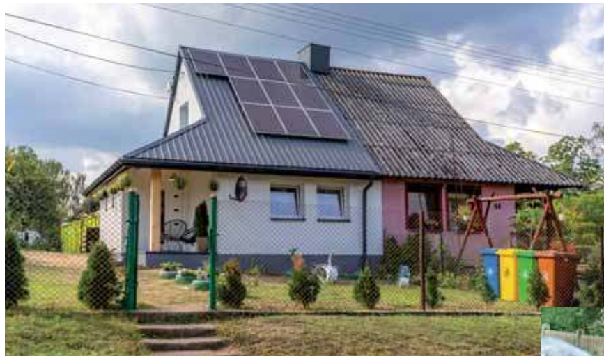
Remont części domu, należącej do pani Agnieszki, trwał dokładnie 5,5 dnia
