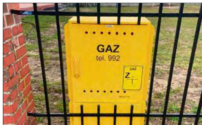
W 2023 roku zmodernizowano system centralnego ogrzewania w budynku Szkoły Podstawowej w Dobrej. Wartość zadania wyniosła 82 184,99 zł.
