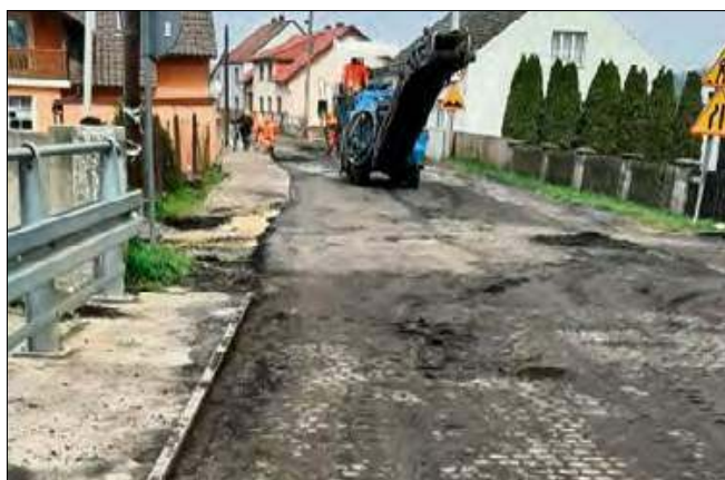
Największą inwestycją była rozbudowa sieci kanalizacyjnej w Strzeleczkach. Łączna wartość zadania wyniosła dokładnie 8 486 665,93 zł.
