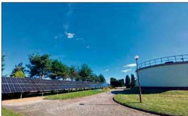
Budowa instalacji fotowoltaicznej na Stacji Uzdatniania Wody w Nowym Budzie. Inwestycja kosztowała 177 939,30 zł.
