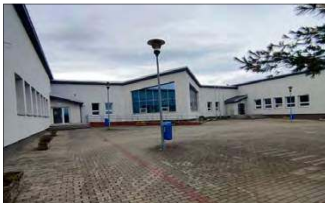
Kolejną ogromną inwestycją była termomodernizacja budynku Szkoły Podstawowej w Strzeleczkach. Wartość łączna zadania wyniosła 4 775 571,95 zł.
