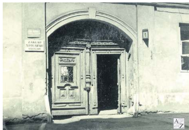
Brama kamienicy przy ul. Kołłątaja (obecnie wejście do hotelu). Zdjęcie z lat 60. ub. wieku. Wykonała je Maria Matuszewska. Ze zbiorów APZ
