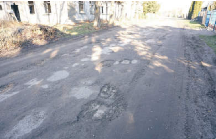
Gmina Grębków chce odbudować tę rozspującą się drogę w Gałkach.
