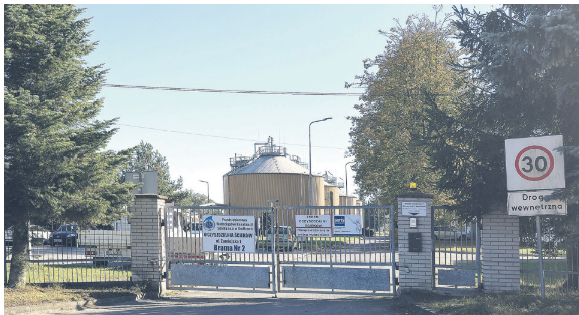
Oczyszczalnia ścieków w Strzale – preferowana przez PEC lokalizacja spalarni
