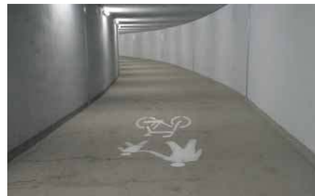
Tunel ma 131 metrów długości
