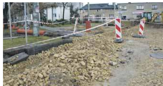
Zastępczyni wójta Świerklańca Anna Kubica informuje, że wykonawca w najgorszym miejscu postara się tymczasowo położyć płyty, by przechodnie nie musieli brnąć przez błoto
