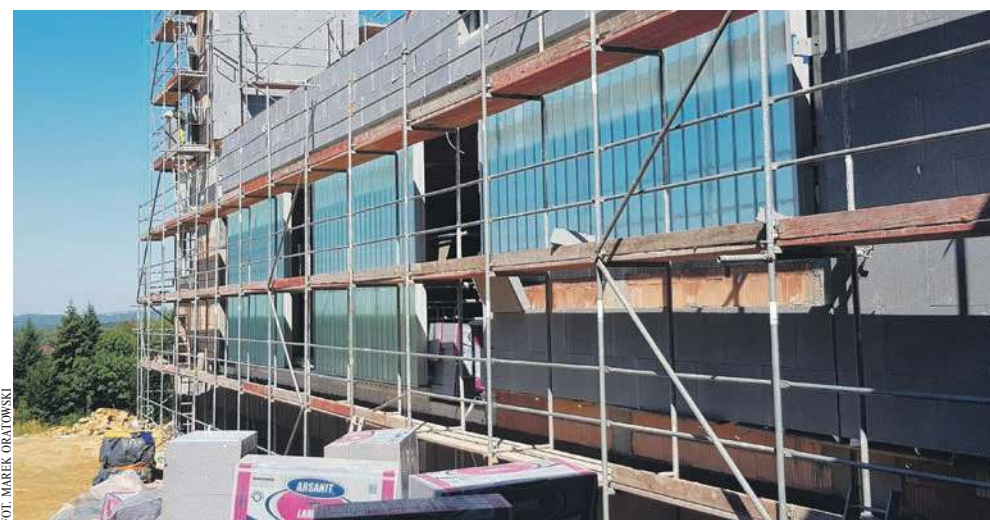
Budowa basenu rozpoczęła się dwa lata temu
