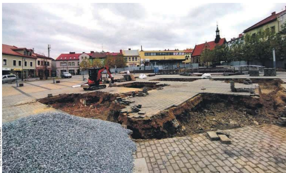
Wykopy w miejscu, gdzie będą tereny zielone na modernizowanym Rynku w Chrzanowie
