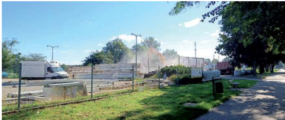
Po salonie Opla nie ma już śladu. Starostwo Powiatowe w Puławach wydało pozwolenie na budowę w tym miejscu obiektu handlowo-usługowego
