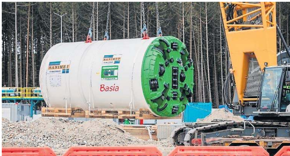
Gazociąg został zbudowany w tunelu drążonym przez specjalną maszynę
