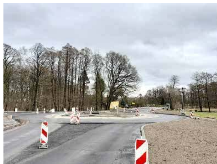
W miejscu skrzyżowania ul. Bolesława Krzywoustego z ul. Zbigniewa Rełigi powstało rondo
