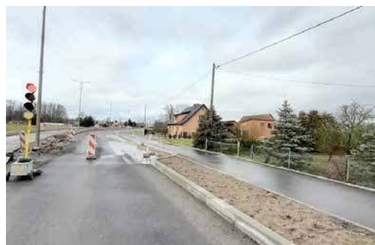
Jak widać prace na drodze są już daleko zaawansowane
