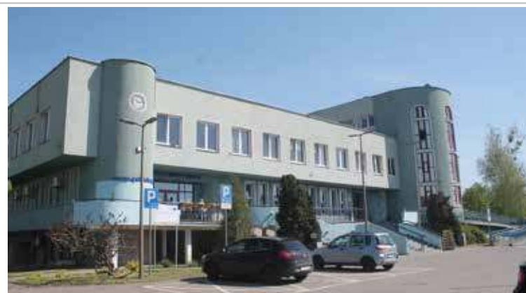
Na dachu gminy we wrześniu ma się odbyć remont poszycia dachowego
