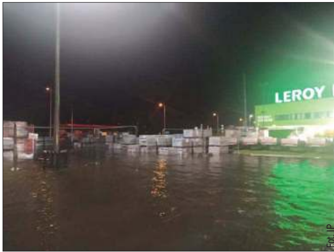
Na parkingu brakuje po prostu odpowiedniego systemu odprowadzania wody.
