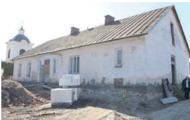
Prace nad modernizacją dawnej plebanii w Baranowie już ruszyły. Prowadzone są pod nadzorem Lubelskiego Wojewódzkiego Konserwatora Zabytków
