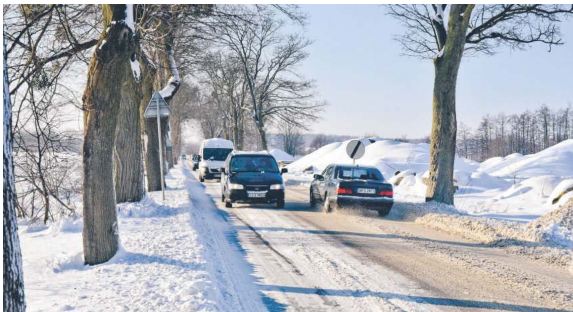
Odcinek drogi nr 224 Godziszewo–Skarszewy jest wąski, dziurawy, a przy nim rosną drzewa | fot. Sebastian Dadaczyński/Gazeta Polska
