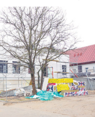
Trwa rozbudowa szpitalnej Izby Przyjęć.
