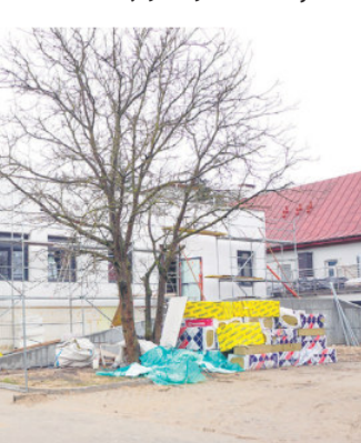
Trwa rozbudowa szpitalnej Izby Przyjęć.
