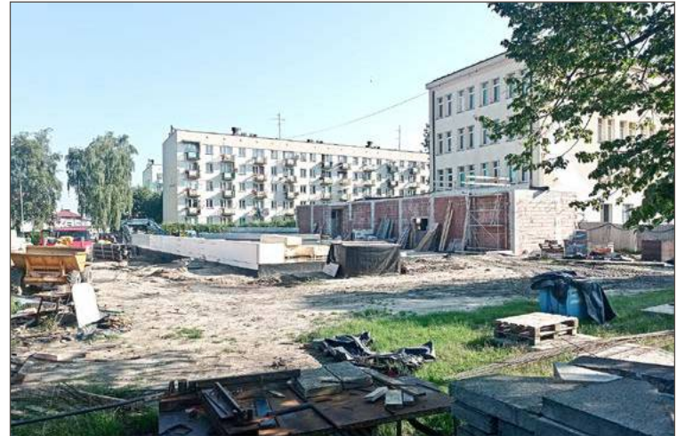
Hala sportowa powstaje obok budynku szkoły.
