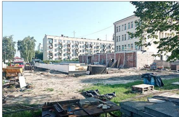
Hala sportowa powstaje obok budynku szkoły.
