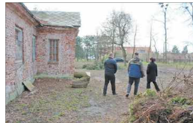
Umowa z wykonawcą na rewitalizację rządcówki i terenu wokół niej już podpisana, rekonesans przeprowadzony. Przyszedł czas na realizację
