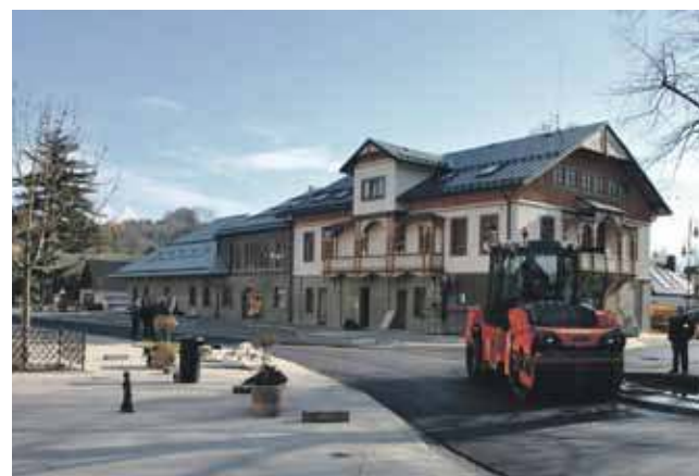
Tak wygląda ostatni etap prac w Krościenku.
