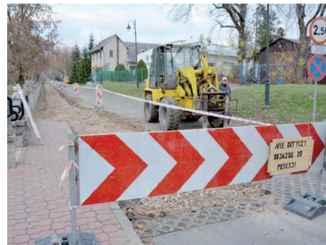
Z powodu budowy, która powinna zakończyć się do 30 listopada, miejsce w którym chętnie parkowali mieszkańcy korzystający z bulwaru, zostało wyłączone z ruchu
