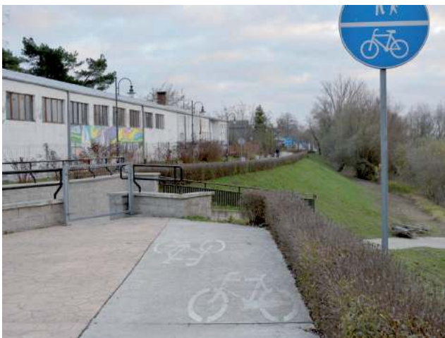
A tu podpowiedź dla władz na kolejną modernizację ścieżki rowerowej nad Wisłą. W dalszej części bulwaru ścieżka niespodziewanie kończy się nad sporym wzniesieniem - to może doprowadzić do wypadku
