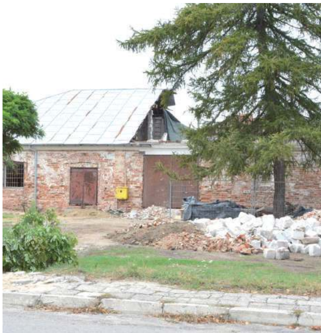
Najwięcej w przyszłym roku ma się dziać w centrum Końskowoli. Ma zostać dokończona trwająca już przebudowa ratusza i rewitalizacja Rynku
