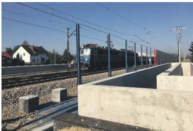
Budowa wiaduktu nad torami w Młoszowej planowana jest w rejonie ul. Trzeciej
