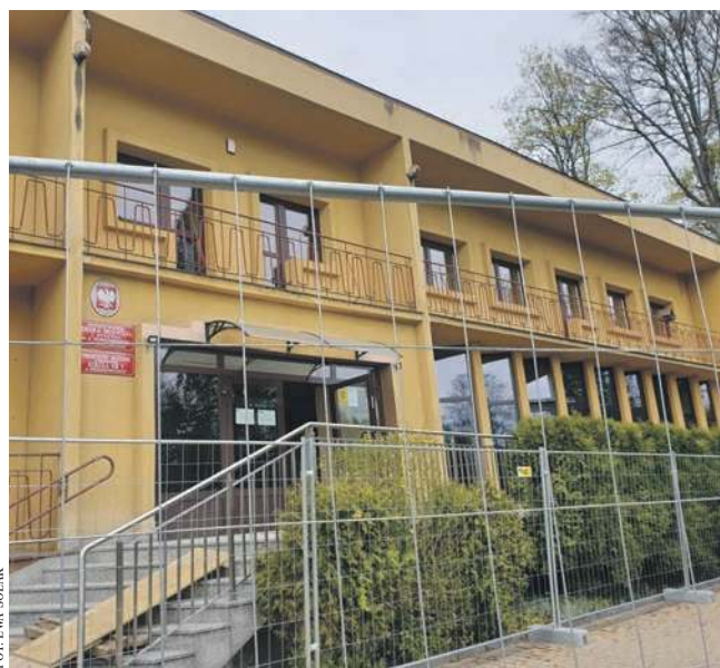
Prace w szkole muzycznej w Krzeszowicach już się rozpoczęły
