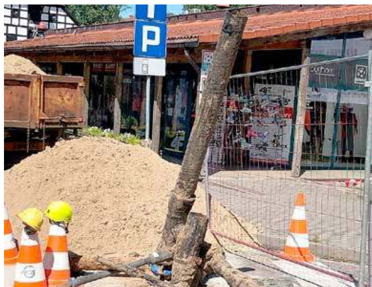
Poza obowiązkiem modernizacji i rozbudowy sieci, GWiK jest też odpowiedzialny za usuwanie awarii, tak, by mieszkańcy mieli zapewniony dostęp do wody i kanalizacji sanitarnej
