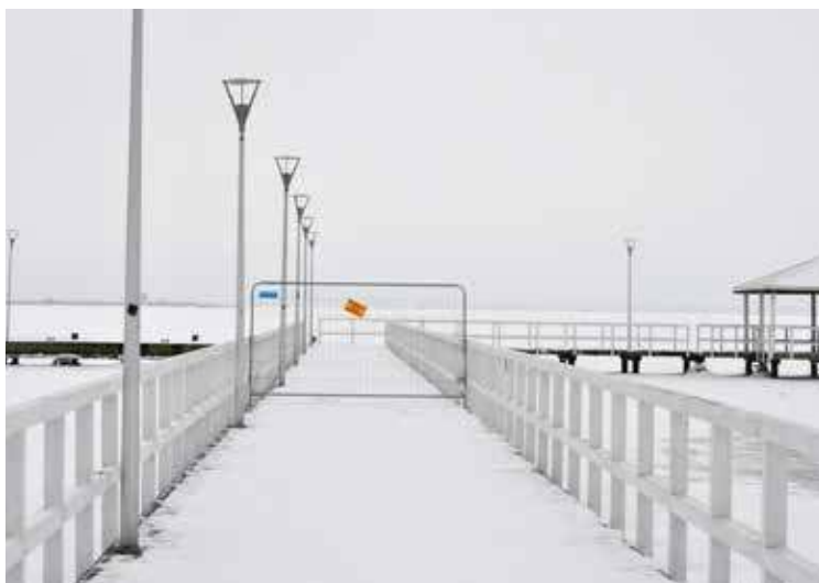
Mimo zimy i śniegu rozpoczęły się prace remontowe na molo w Stepnicy
