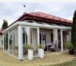
Narożną oranżerię zamontowano na istniejącym tarasie.
