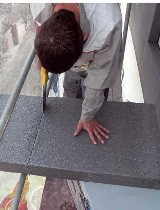
🔧 Bardzo dużo zależy od staranności wykonawców. Dlatego pilnujmy jakości prac. AUSTROTHERM
