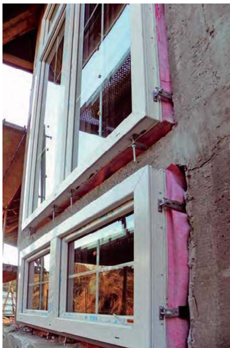
Tylko wysunięcie okien poza lico muru, w warstwę ocieplenia, zastruguje na miano ciepłego montażu. VEKA
