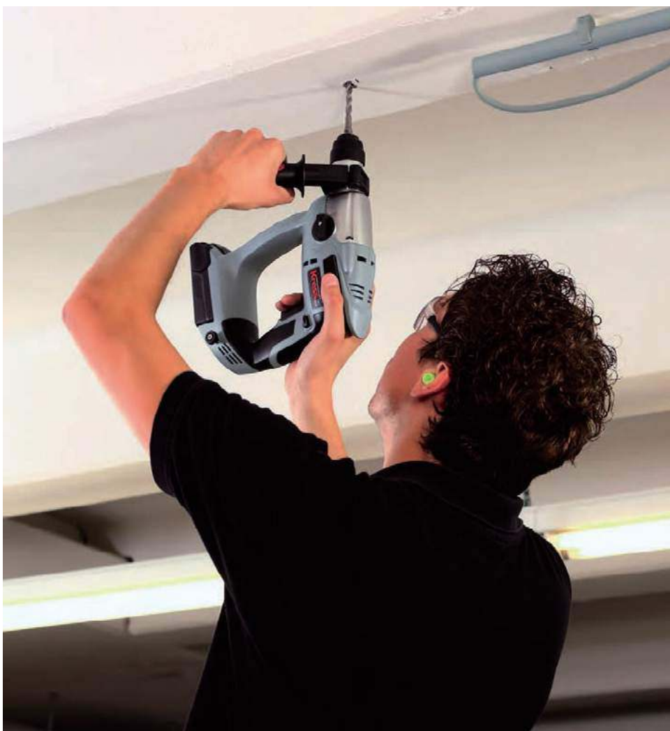
🔧 Młotowiertarką można wiercić w cegle i betonie, a po wyłączeniu udaru – w drewnie i metalu. LANGE ŁUKASZUK (KRESS)
