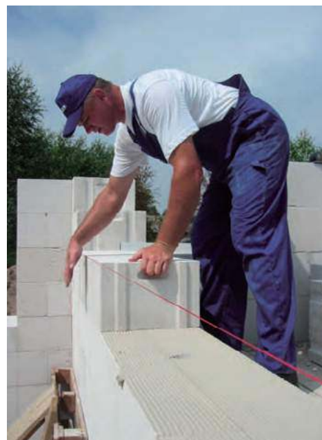
Elementy murowe łączą się na cienkie spoiny, ewentualnie na zaprawę ciepłochronną. SOLBET
