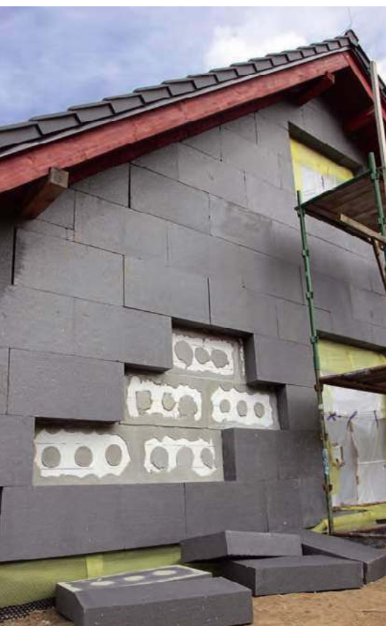
🔧 Prawidłowe docieplanie starych ścian zwykle jest trudniejsze niż nowych. Koszt robocizny i materiałów łącznie z tynkiem cienkowarstwowym to 100–150 zł/m 2 . SWISSPOR
