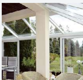
Profile z aluminium przykręcono do więźby pod okapem dachu.
