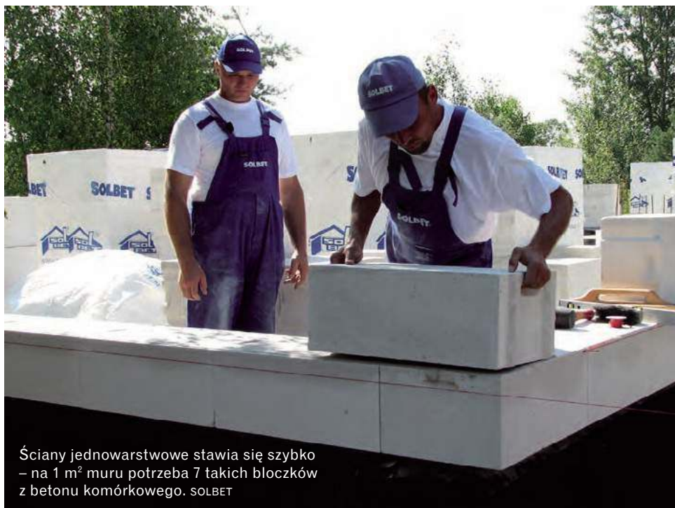
Elementy murowe łączą się na cienkie spoiny, ewentualnie na zaprawę ciepłochronną. SOLBET
