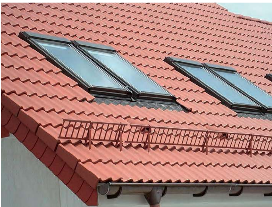
🔦 Podczas układania dachówek nie można zapomnieć o zamocowaniu niezbędnych akcesoriów. Na zdjęciu płotki przeciwnieźne, których rolą jest zatrzymanie na dachu dużych mas śniegu. IBF
