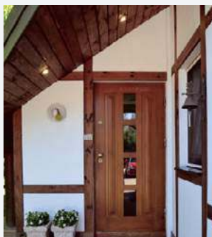
W podbitce domu i garażu zamontowano oczka z żarówkami energooszczędnymi.
