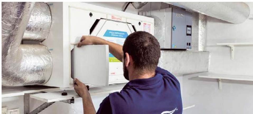
🔧 Montaż elektro-jonizacyjnego filtra antysmogowego w centrali wentylacji mechanicznej. Dzięki niemu możliwe jest zatrzymanie z powietrza napływającego do wnętrza budynku cząstek stałych nawet o średnicy 1 \mu\text{m} . PRO-VENT
