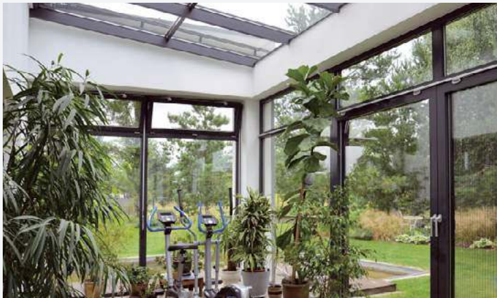
W pionowych oknach są uchylne łufiki. Dach jest przeszklony.
