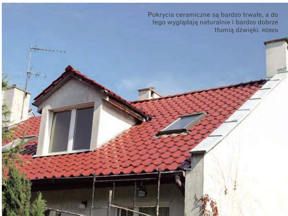
❶ Dachówki ceramiczne (a CREATON) i cementowe (b IBF) to niewielkie elementy, dlatego można nimi kryć również dachy o bardziej skomplikowanych kształtach – bez obaw, że podczas prac dekarских powstanie dużo odpadów.
