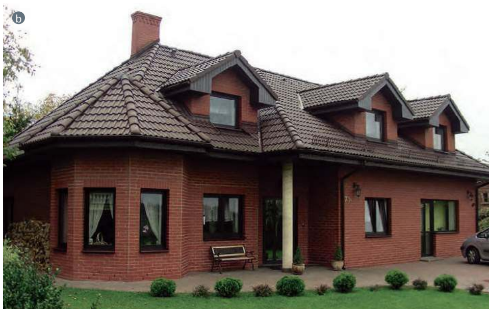
❶ Dachówki ceramiczne (a CREATON) i cementowe (b IBF) to niewielkie elementy, dlatego można nimi kryć również dachy o bardziej skomplikowanych kształtach – bez obaw, że podczas prac dekarских powstanie dużo odpadów.
