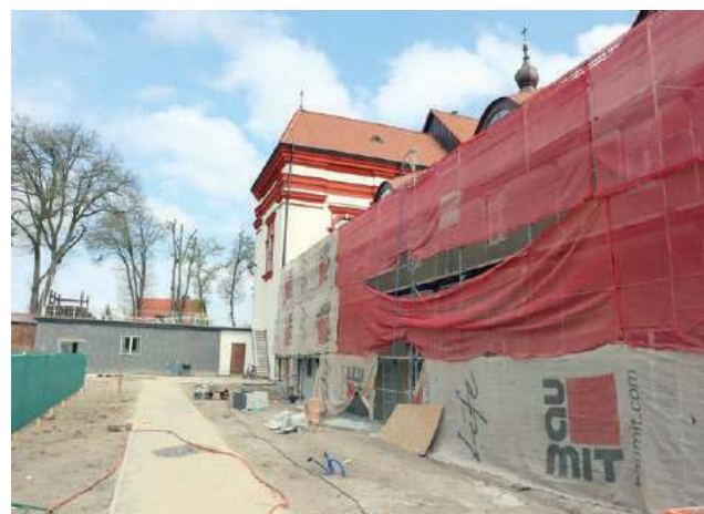
Prace konserwatorsko-budowlane przy elewacji tylnej budynku klasztornego.
