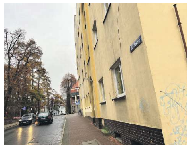
Lokatorzy zasiedlili mieszkania. Zakończona przebudowa nie uzyskała pozwolenia na użytkowanie
