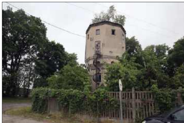
Wieża ciśnień z 1898 roku to element kompleksu dworcowego w Parczewie
