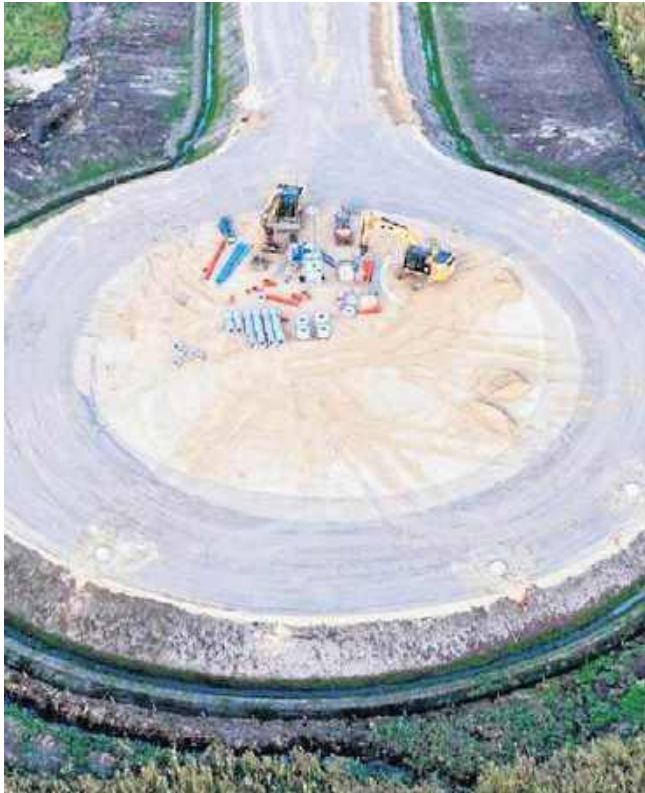
W 2027 r. mają zakończyć się prace na „ostatniej mili”, rok później zaś gotowe powinny być pozostałe odcinki
