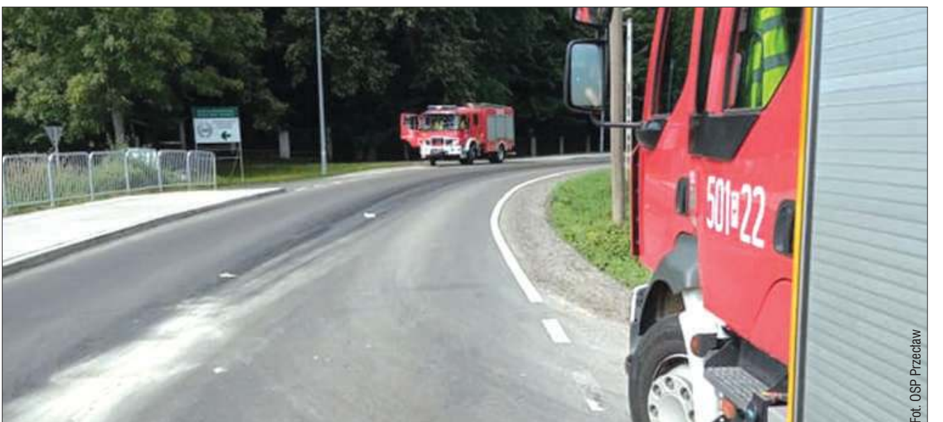
Wykonane uszczelnienie emulsją asfaltową nie zdążyło wyschnąć.
