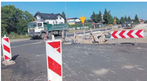
W mieście realizowanych jest sporo inwestycji drogowych. Na skrzyżowaniu Okrzei i Dzieci Zamojszczyzny budowane jest rondo.
