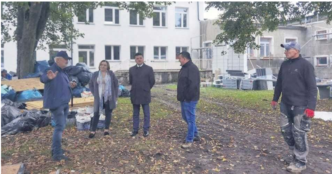
Wójt Łukasz Kłębek ogląda prowadzonych w gminie Ulhówek inwestycji. Regularnie sprawdza m.in. jak przebiega termomodernizacja szkoły w Ulhówku. Na profilu „Nasza Gmina Ulhówek” z jego polecenia zamieszczane są informacje o kolejnych i licznych działaniach gminy.
