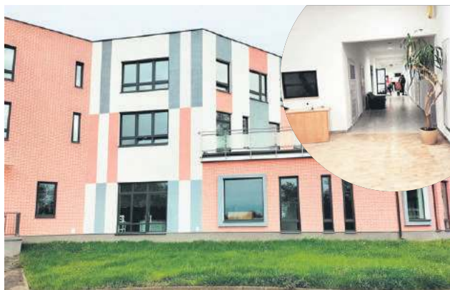
Rodzinny Dom wygląda imponująco. Budynek czeka na odbiór techniczny.
