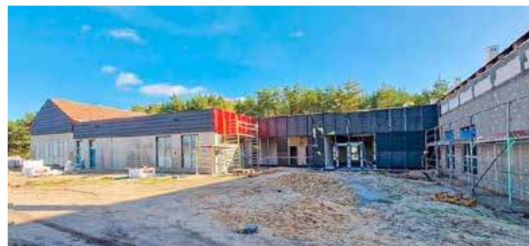
Prace budowlane przedszkola i świetlicy wiejskiej idą zgodnie z harmonogramem (fot. Gm. Goleniów)
