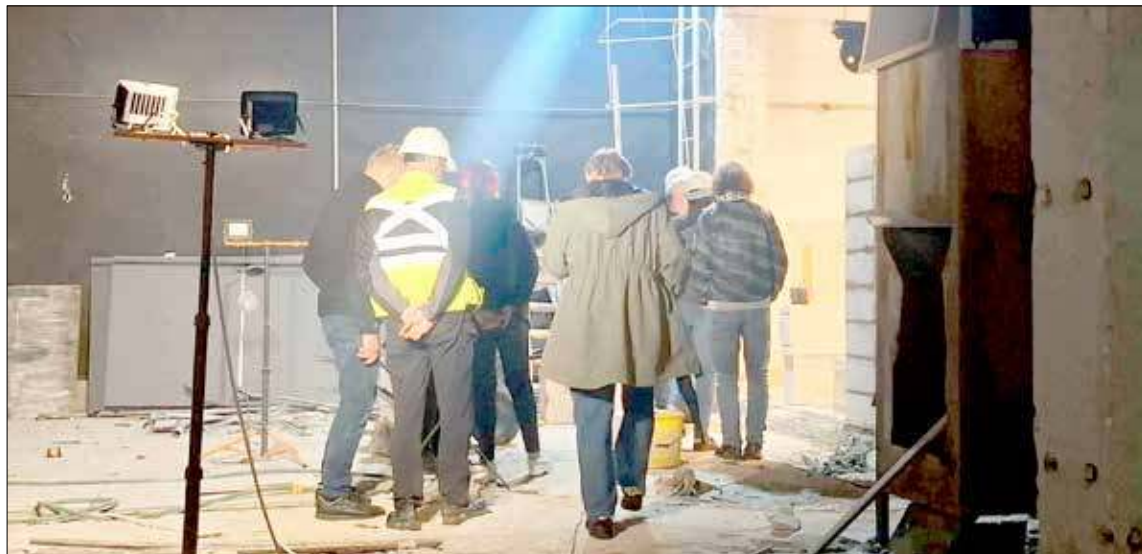
Po roku nadal trwa false flag - Oj uwierzcie, że dzieje się tam naprawdę dużo - piszą na stronie NDK w czwartek pracownicy NDK zwiedzający rzekomą „budowę”... rzeczywiście wielkiej wiary trzeba kiedy faktów brak a jeśli nawet jakieś są to w ramach samowoli budowlanej skoro nadal nie ma pozwolenia na budowę
