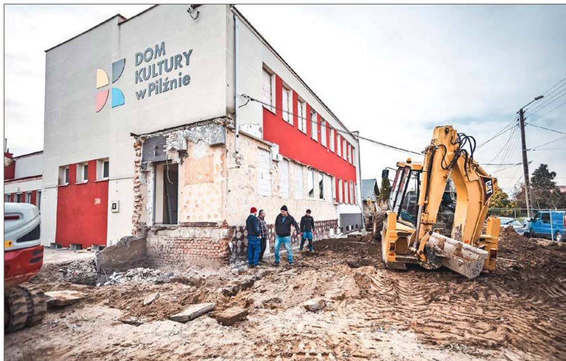
Nowa klatka schodowa i winda powstaną po prawej stronie od dawnego wejścia.
