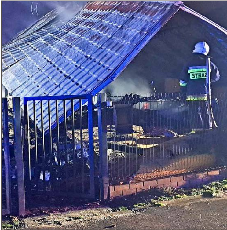
Z domu przy ul. Osiedlowej nie zostało wiele.
