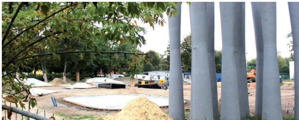
W tej chwili tak wygląda przebudowa puławskiego skateparku. Teren zyska zupełnie inną nawierzchnię. Młodzież po otwarciu będzie spędzała wolny czas jeżdżąc na desce, BMX-ie bądź hulajnodze
