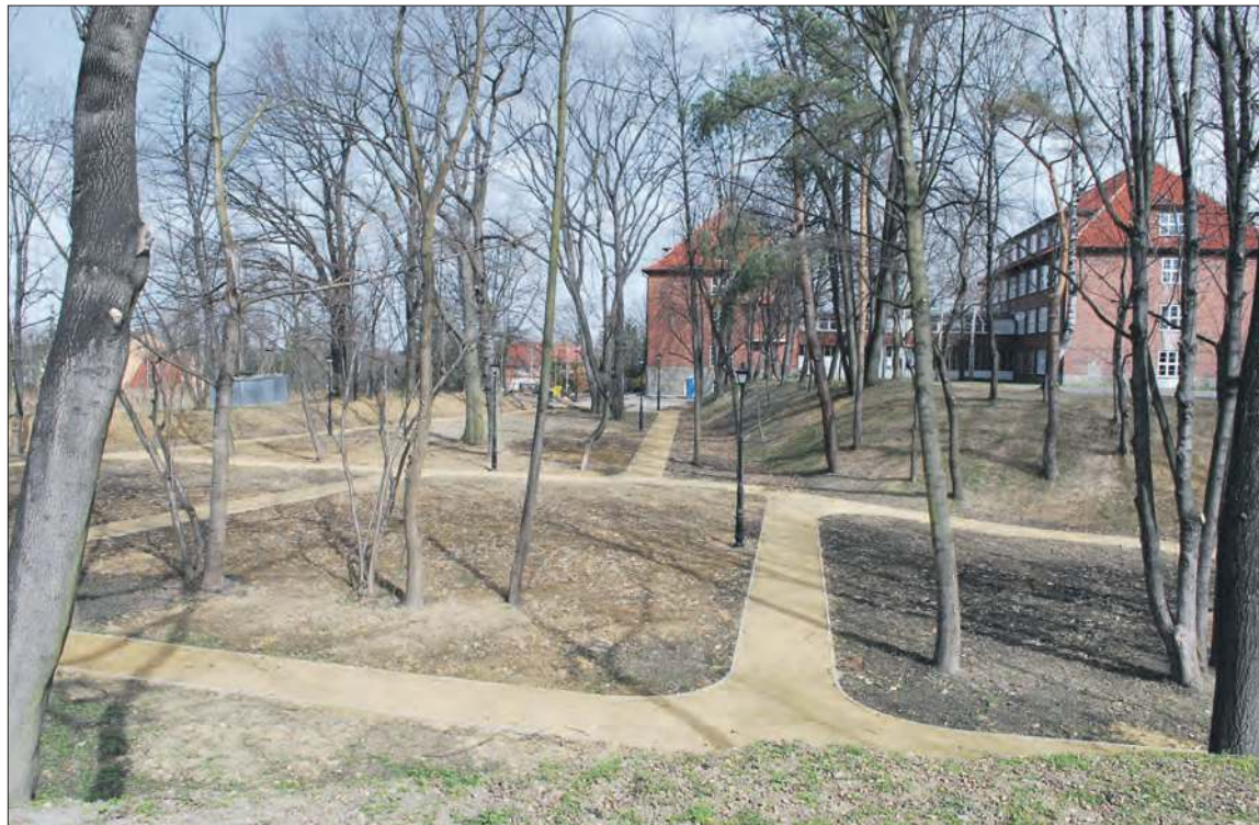
Budowa ogrodu dla pszczół
