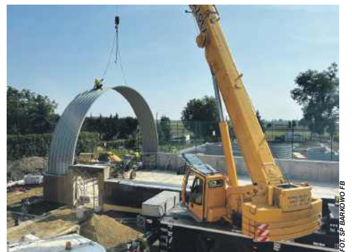
W Barkowie trwa budowa hali sportowej
