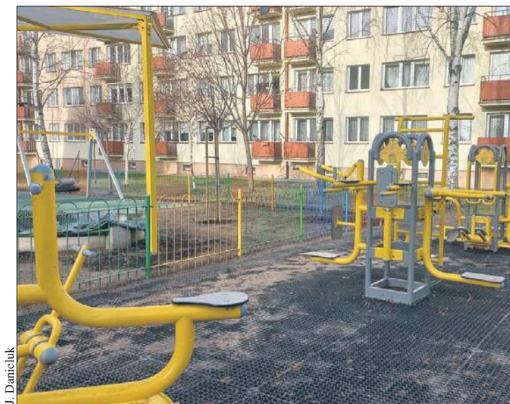
Zapadnięte maty przerostowe pod urządzeniami do ćwiczeń na placu zabaw przy ul. Gawareckiego 3
