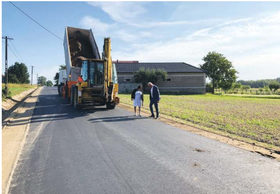
Wicestarosta Paweł Calak z gospodarską wizytą przy przebudowie drogi
