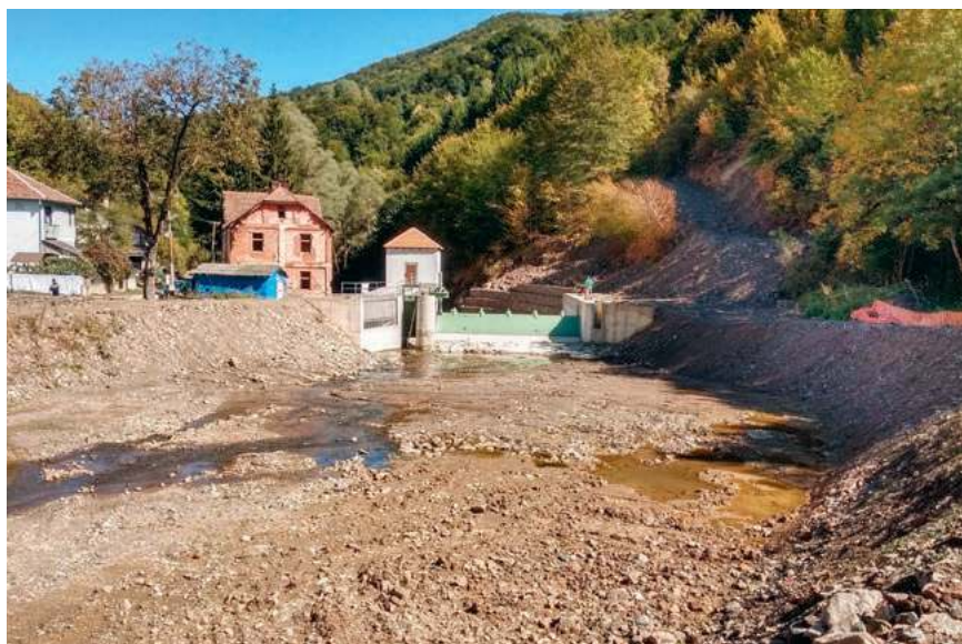
Wyschnięte koryto rzeki Rakita po zbudowaniu elektrowni wodnej, wrzesień 2019 r.
