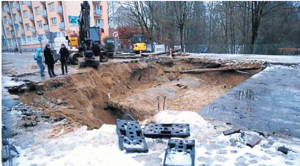
Podczas prac na ulicy Zwycięstwa w Koszalinie odkopano stary tunel. Przejście podziemne podczas wojny Niemcy zamienili na schron przeciwlotniczy.
