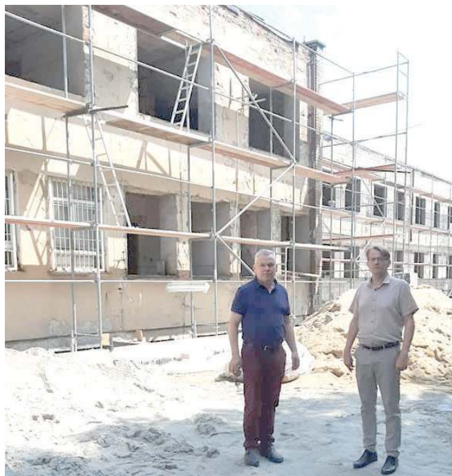
Starosta łukowski Dariusz Szustek i Władysław Karaś, radny Rady Powiatu Łukowskiego przed remontowanym budynkiem przychodni zdrowia w Stoczku. Budynek przechodzi gruntowną modernizację od piwnic aż po dach
