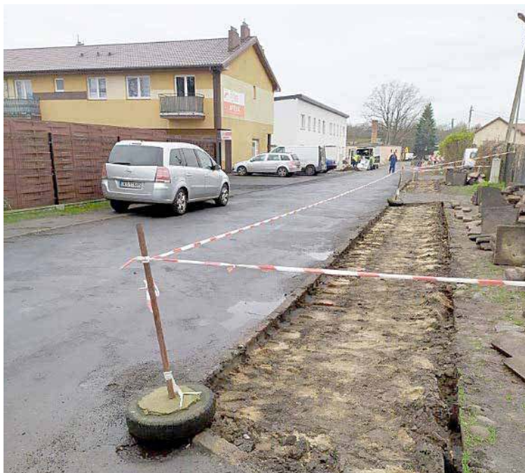
W tym miejscu inwestor włączył się do sieci wod.-kan. biegnącej pod jezdnią
