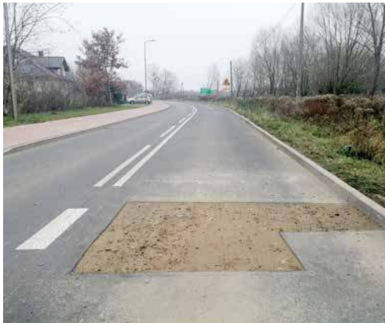
W tym miejscu inwestor włączył się do sieci wod.-kan. biegnącej pod jezdnią
