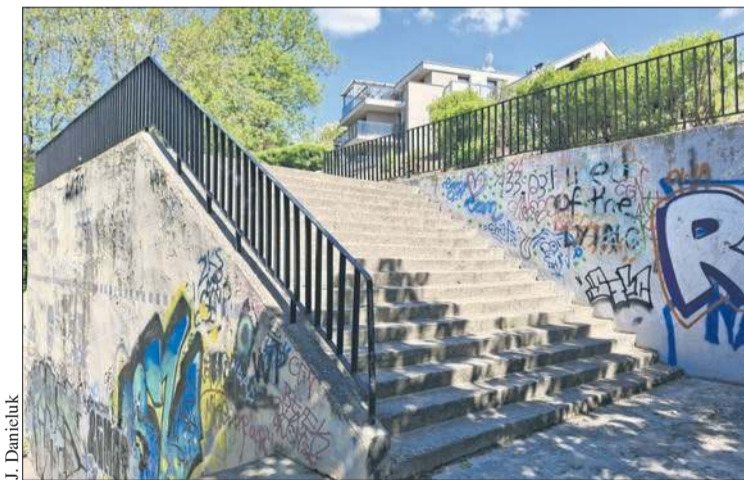
Schody prowadzące od skrzyżowania ulic Kazimierza Wielkiego i Okrzei nad Wisłę
