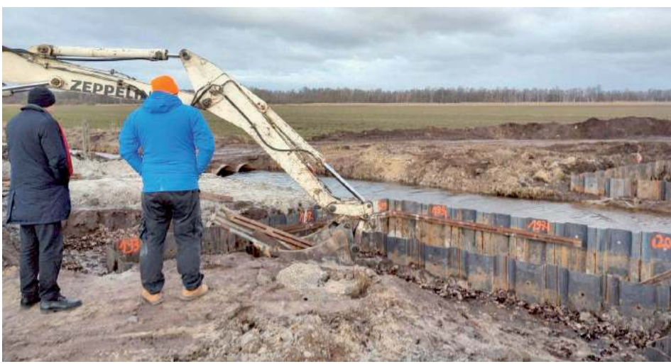
Drewniany most na Białce w Ostrówkach w gm. Wołyn zastąpi przeprawa betonowa
