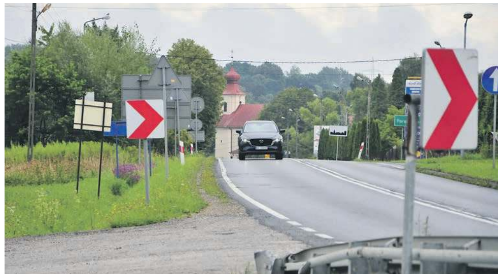
Chodnik powstanie od ul. Krakowskiej w Alwerni do granicy z Porębą Żegoty
