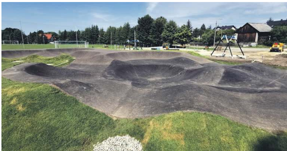
Pumptrack jest już prawie gotowy
