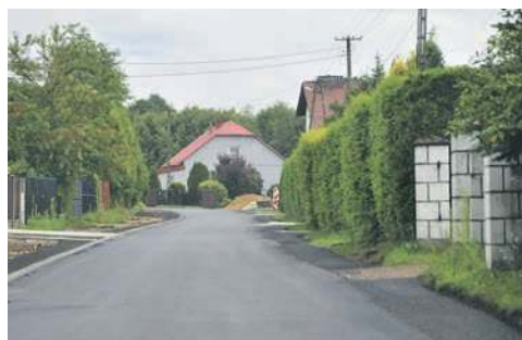
Remontowana droga z Alwerni do Brodeł
