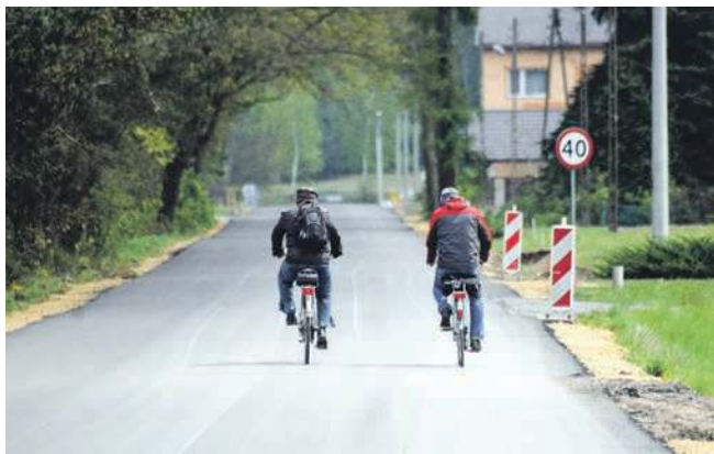
Gładka jak stół ulica Krasickiego w Alwerni
