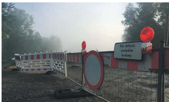
Wiadukt na ulicy Słowackiego w Trzebini ma być gotowy najwcześniej z końcem sierpnia tego roku
